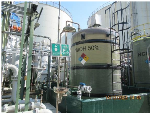
ภาพที่ 2-27 ถังเก็บสารละลาย NaOH
