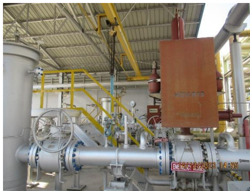
ภาพที่ 2-36 วาล์วควบคุมการจ่ายก๊าซ
