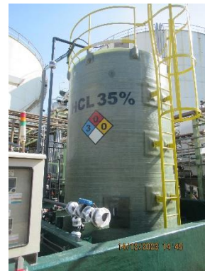
ภาพที่ 2-28 ถังเก็บสารละลาย HCl
