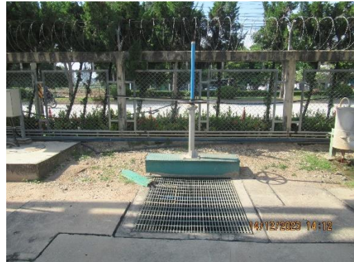
ภาพที่ 2-9 ประตูละบายน้ำของรางระบายน้ำฝน
