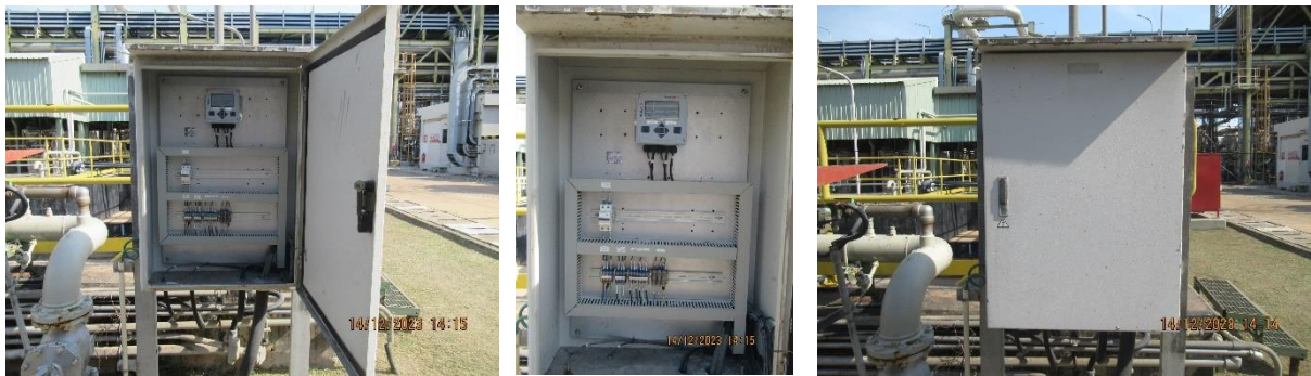
ภาพที่ 2-4 การติดตั้งเครื่องมือตรวจวัดคุณภาพน้ำอัตโนมัติ
