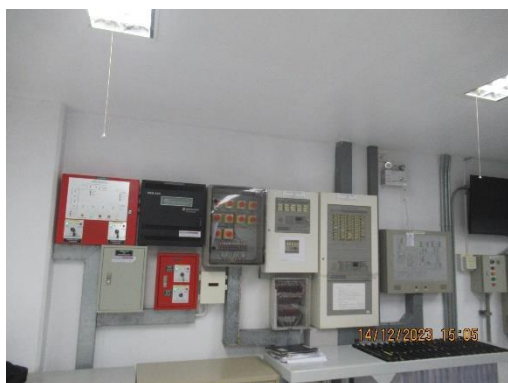
ภาพที่ 2-32 ตู้ควบคุมสัญญาณเตือนต่างๆ
