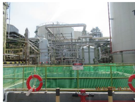
ภาพที่ 2-5 ถังปรับสภาพ (Neutralization Basin)
