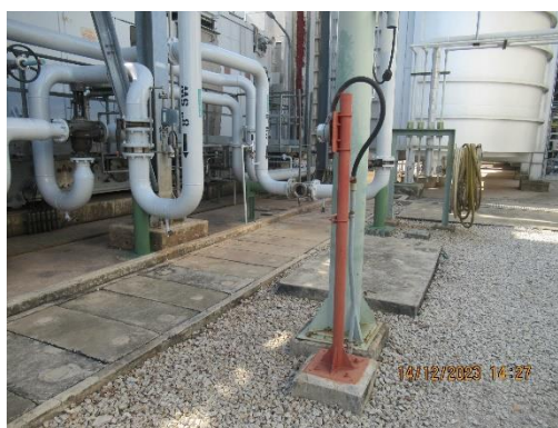
ภาพที่ 2-31 Gas Detector และ Ammonia Detector
